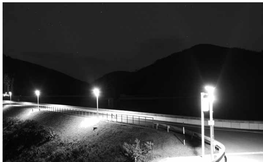
Osvětlení vodní nádrže Šance. Foto: J. Kondziolka
